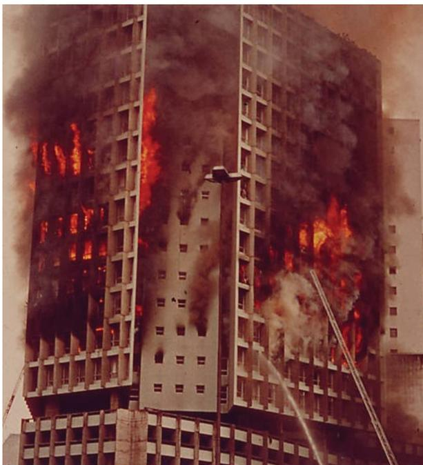
**Figura 5** - Propagação por condução (contato direto das chamas)
