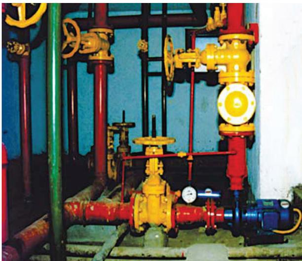
Figura 43 - Bomba de incêndio e acessórios hidráulicos
