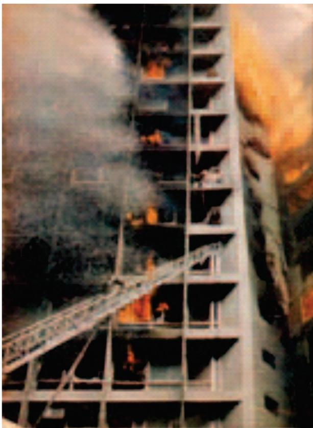
**Figura 6** - Propagação por convecção, em que gases quentes fazem com que ocorra focos de incêndio em andares distintos
